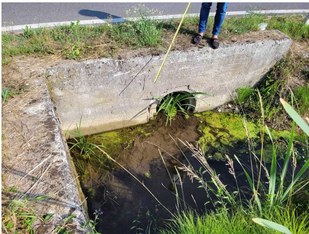
Foto 2 Attraversamento raccordo stradale tra la SP65 e via Campocroce. Imbocco Ø600 mm.
