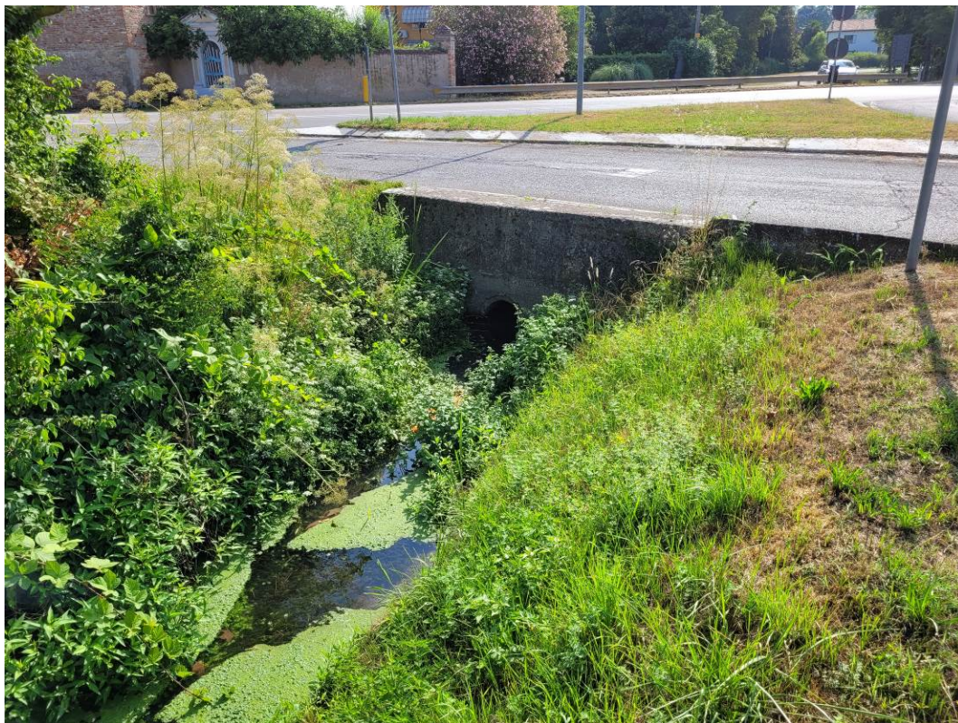
Foto 1 Imbocco del tombinamento che crea continuità da Ovest e Est della SP65 via Kennedy (scorrimento verso est). Non risulta possibile verificare la continuità verso il Bimbari per la presenza di tombinamenti e tratti di fossato interrati
